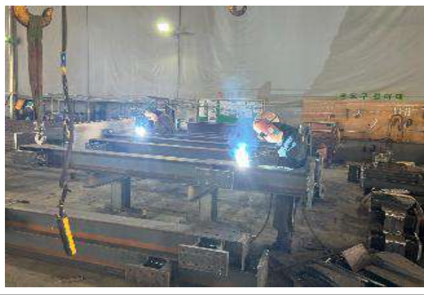
▲ Pipe Rack 제작
